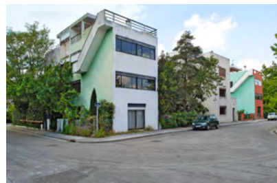
Cité Frugès de Pessac ist der Prototyp eines Quartiers mit standardisierten Gebäuden
